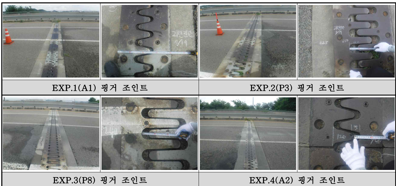
<그림 3.3.5> 상신육교(향남방향, 본선) 신축이음 설치현황
