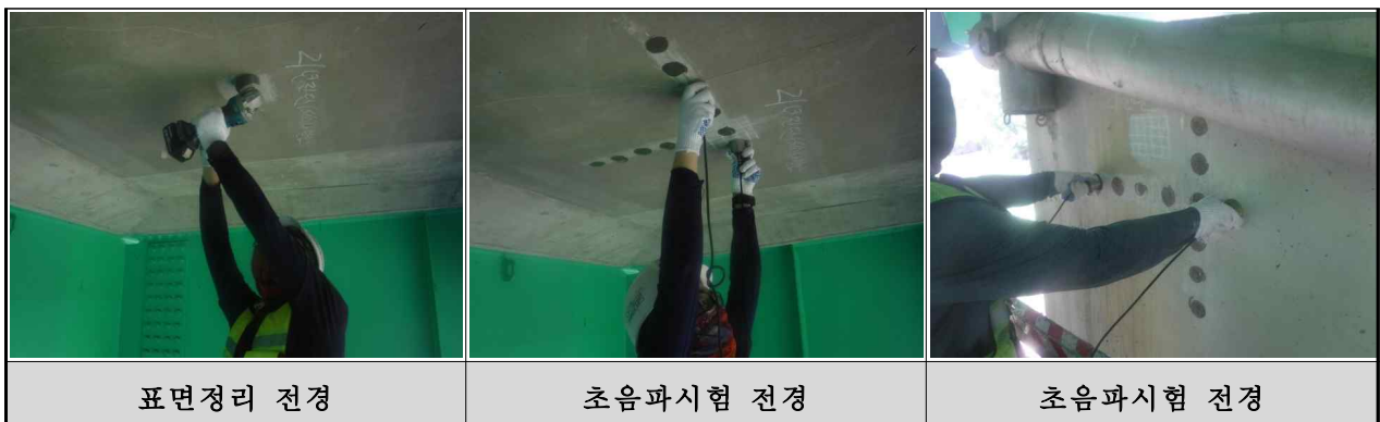
&lt;그림 3.4.4&gt; 상신육교(발안IC방향, 본선) 초음파시험 전경
