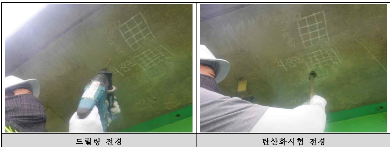
&lt;그림 3.4.18&gt; 상신육교(발안IC방향, 램프) 탄산화시험 전경
