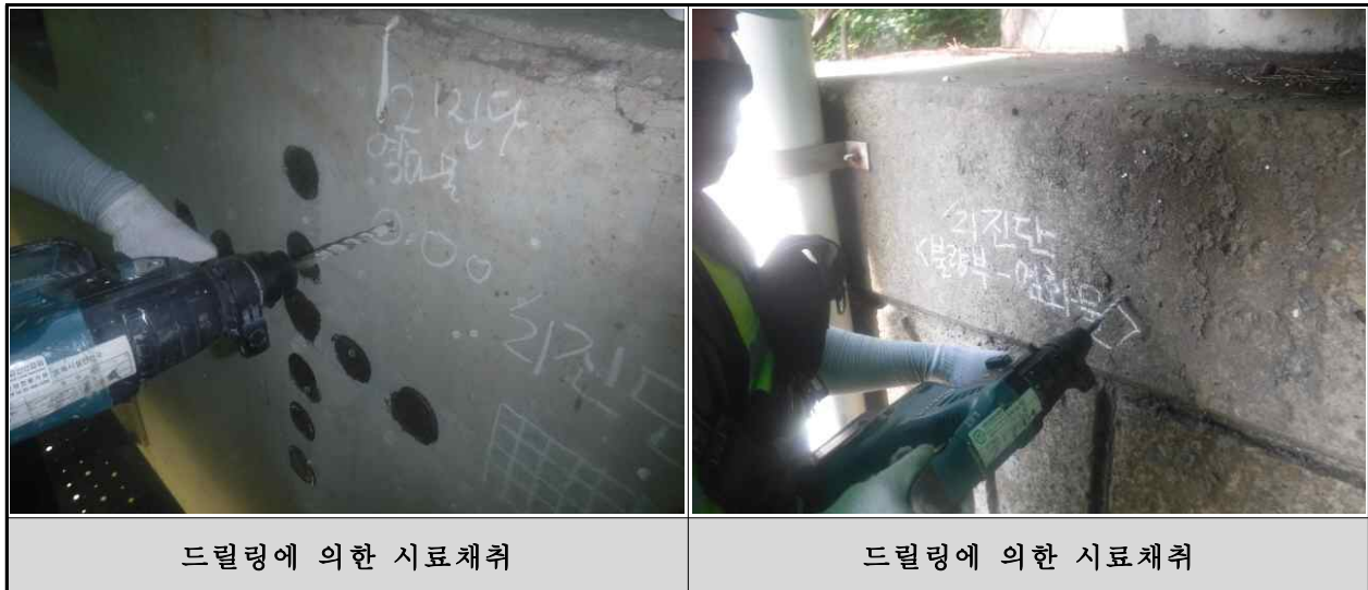
<그림 3.4.32> 상신육교(향남방향, 본선) 염화물 시료 채취 진경
