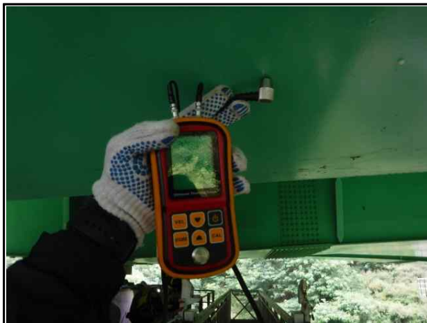
외부 강재두께 측정
