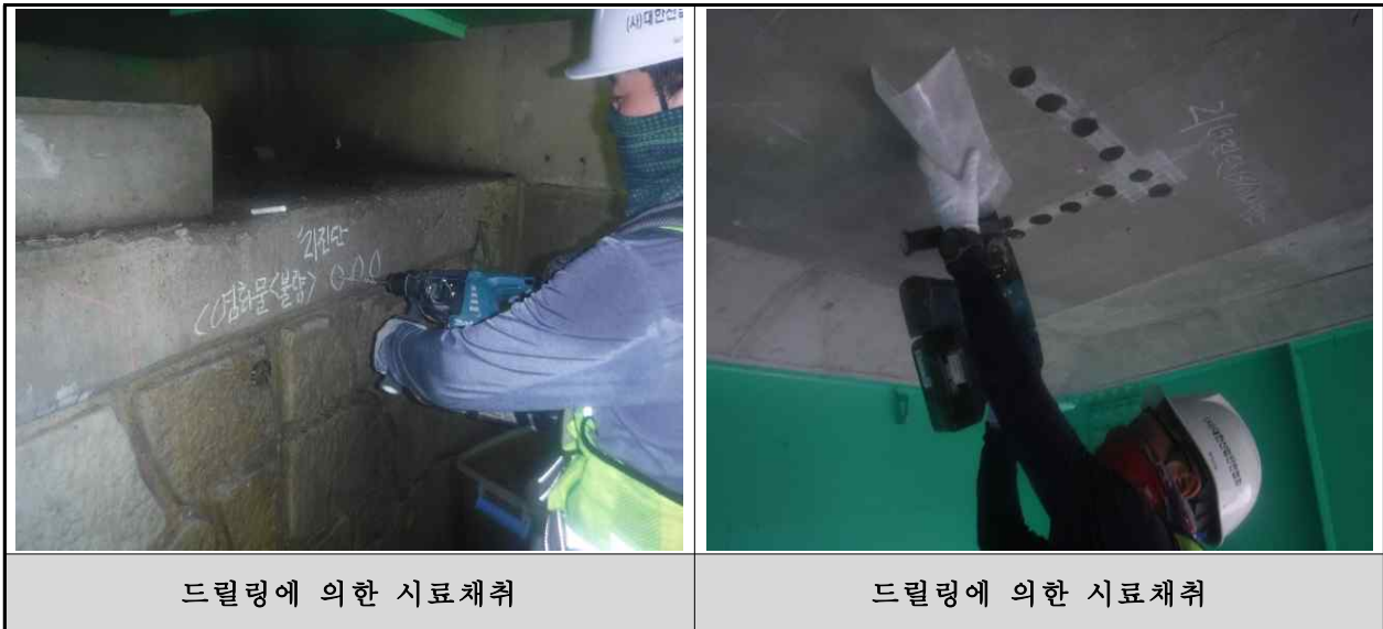
<그림 3.4.9> 상신육교(발안IC방향, 본선) 염화물 시료 채취 전경
