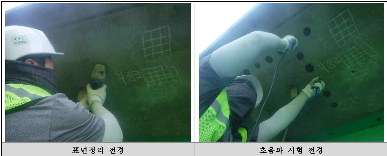
<그림 3.4.16> 상신육교(발안IC방향, 램프) 초음파시험 전경
