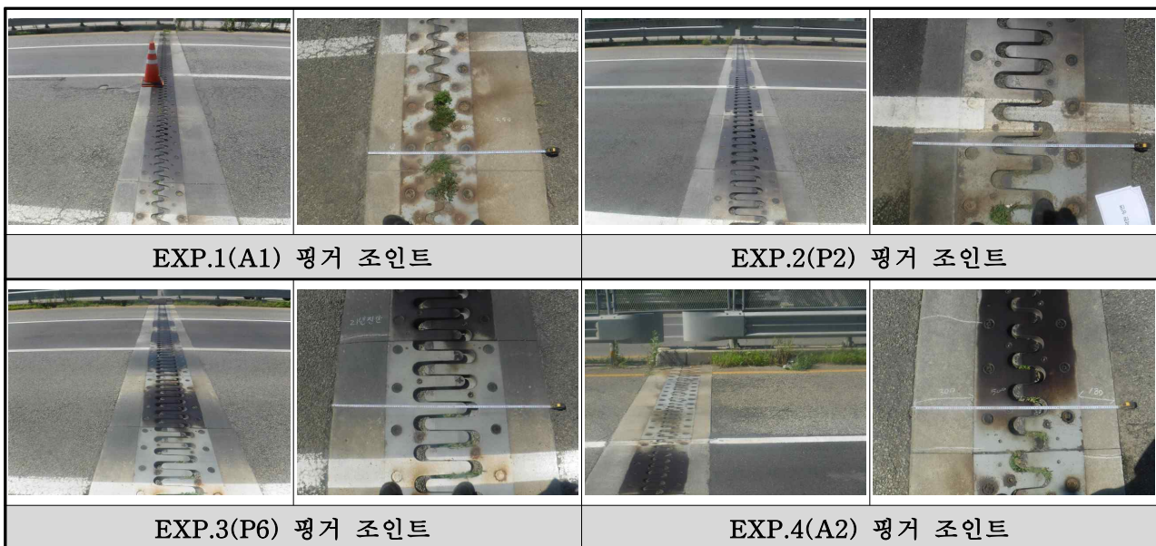
<그림 3.2.5> 상신육교(발안IC방향, 본선) 신축이음 설치현황
