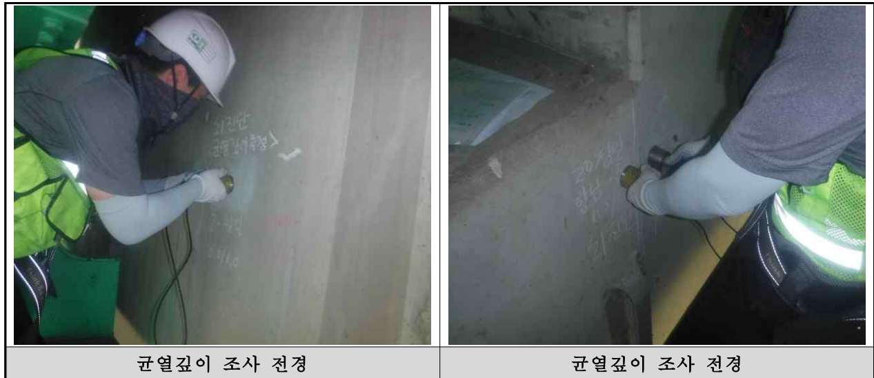
&lt;그림 3.4.35&gt; 상신육교(향남방향, 본선) 균열깊이 조사 전경
