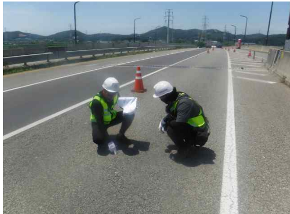
교면포장부 교통통제 후 현장조사
