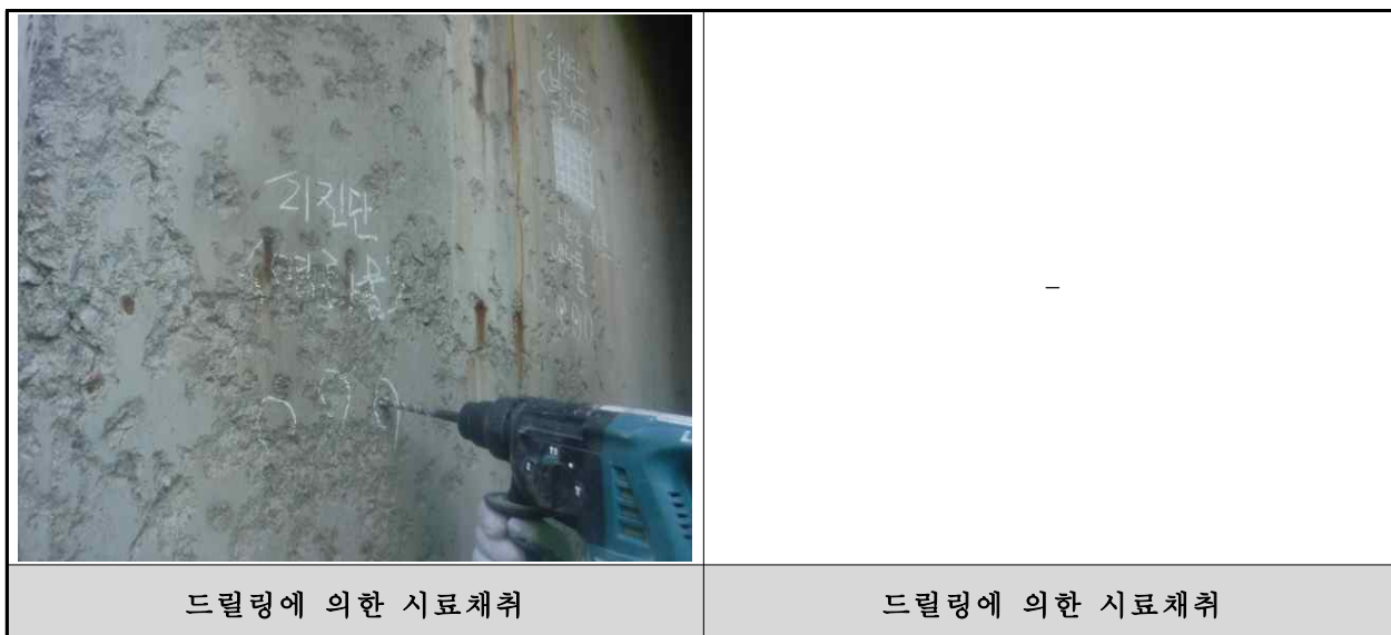
<그림 3.4.20> 상신육교(발안IC방향, 램프) 염화물 시료 채취 전경
