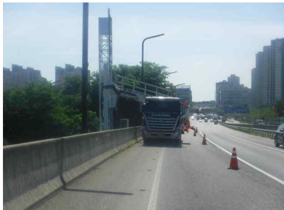
교통통제 후 교량점검차 이용한 현장조사
