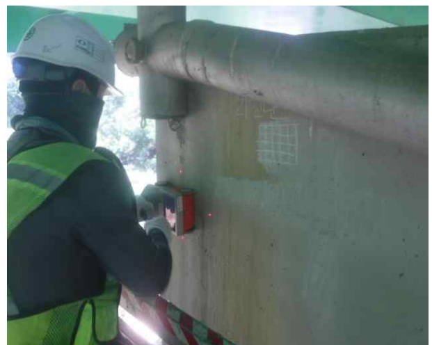
철근배근 및 피복조사
